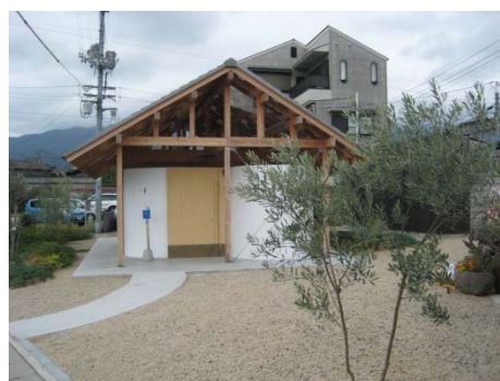
町が整備したモダンなトイレ(小豆島町)
