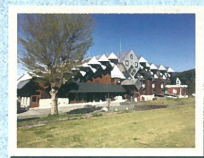
山々に囲まれた人気の研修施設「木魂館」
